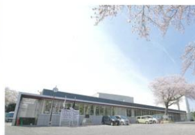
管理棟1号館 2011年完成
